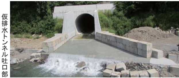
仮排水トンネル呑口部
