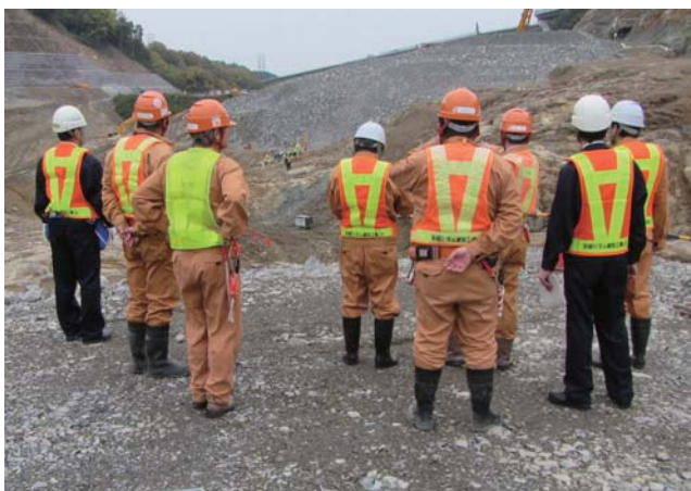
大阪労働局による現場視察
